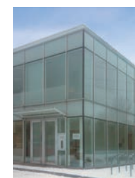
Fujitsu General (UK) Co., Ltd. (UK)
